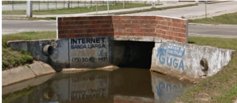
Figura 4 -Ligações das galerias em aba de bueiro
