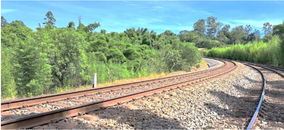
Figura 6. Essa curva teve uma restrição de velocidade temporária devido a um alto índice de L/V de roda. Raio de 174 m em bitola larga. Velocidade autorizada de 60 km/h.
