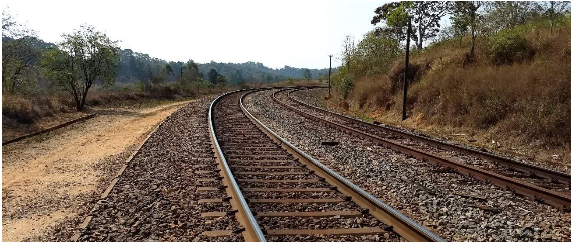
Figura 8. Essa transição de curva apresentou resultados elevados de alívio de roda em simulação a 64 km/h. A velocidade máxima autorizada foi mantida em 60 km/h.
