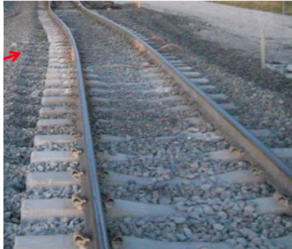
Figura 9. Deslocamento lateral da grade após a passagem de várias composições (SCOTT CUMMINGS; RB WILEY; DWIGHT CLARK, 2016)
