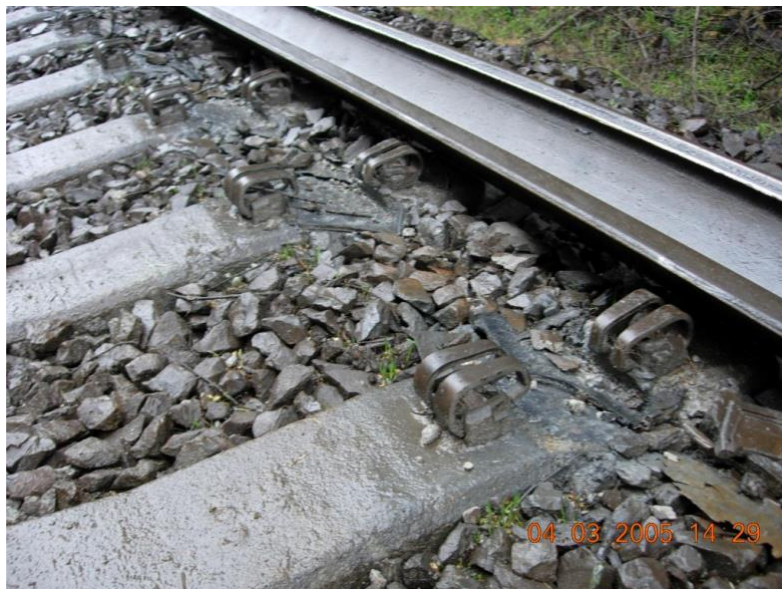
Figura 4. Quadramento de trilhos nos EUA em curva com degradação do dormente na região da mesa de apoio (MARQUIS; MUHLANGER; JEONG, 2012).
