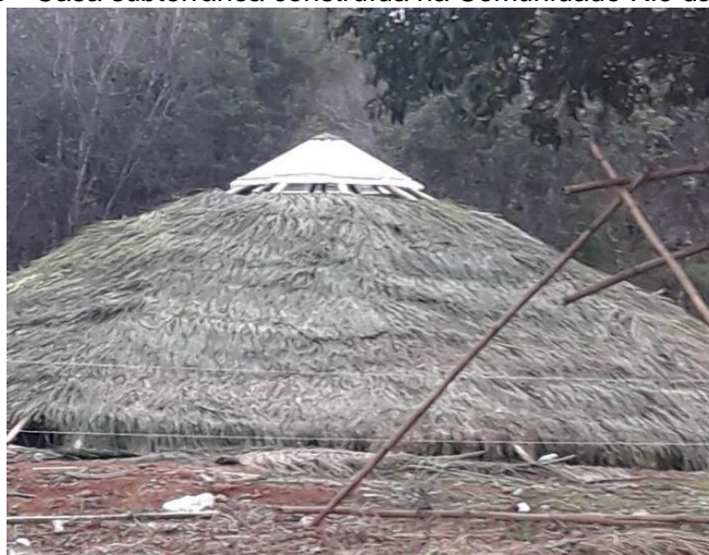
Figura 1 - Casa subterrânea construída na Comunidade Rio das Cobras
