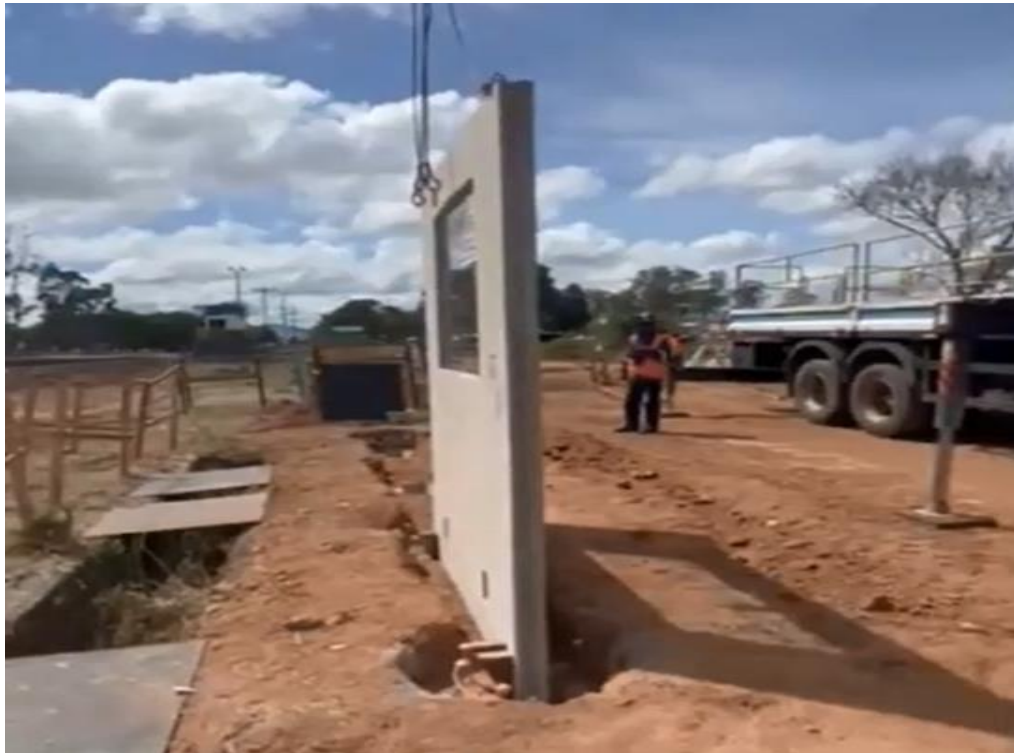
Figura 3. Posicionamento da placa tipo 2 após a primeira etapa de concretagem
