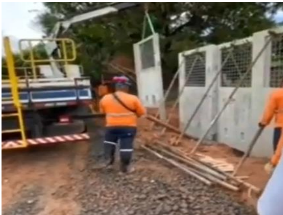
Figura 4. Içamento da placa tipo 1 e indicação de escoramento
