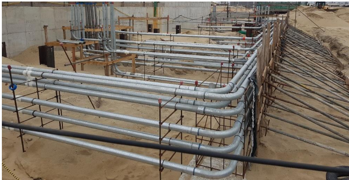
Figura 4 – Foto do local de aplicação
