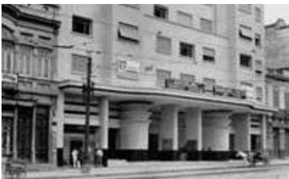
(a) Fachada do Cine Ufa-Palácio Fonte: Anelli, 2001
