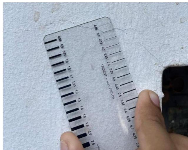
Figura 10 – Fissurometro sendo usado.
