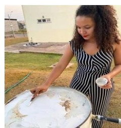
Figura 4. Eliminação e reparo de furos na bomba
