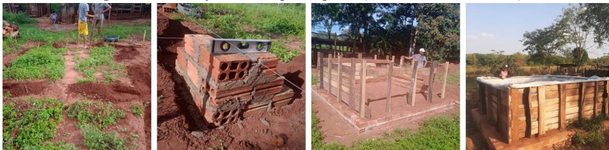
Figura 1: Construções do tanque de peixe (Módulo de Piscicultura).
