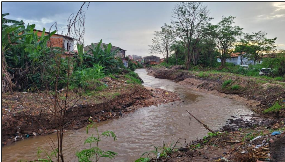
Figura 2- Construções às margens do riacho.
