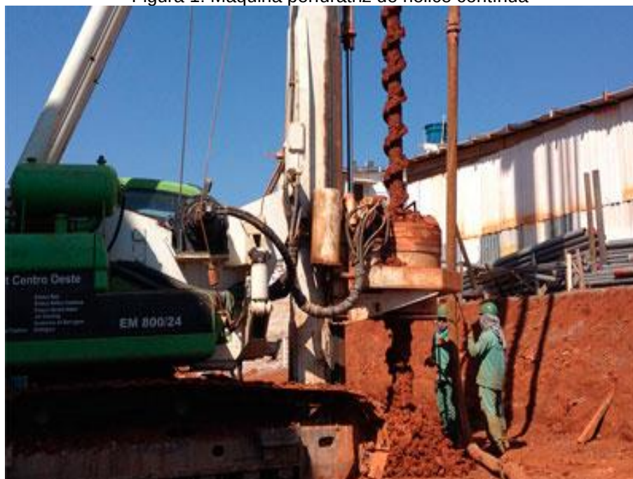
Figura 1: Máquina perfuratriz de hélice contínua
