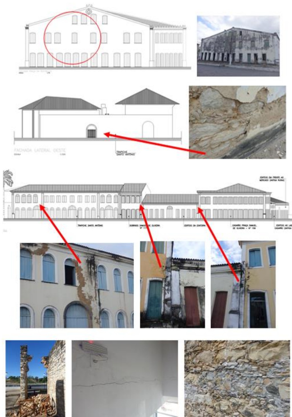
Figura 4- (acima): Fachada da Biblioteca (Casarão do Oitão) e vista geral do estado de conservação atual. (centro acima): Fachada lateral esquerda do campus e degradações com perda do reboco. (abaixo acima): Fachada principal do Campus de Laranjeiras e degradações das mais variadas. (abaixo): esquerda – Queda de um dos arcos em abril de 2017, centro – Fissuras no Casarão 159, direita – Uso de cimento para preenchimento de lacunas nas paredes de pedra. Fonte: Planta PCL 2009 e Fotos dos autores, abr. e ago. 2017.
