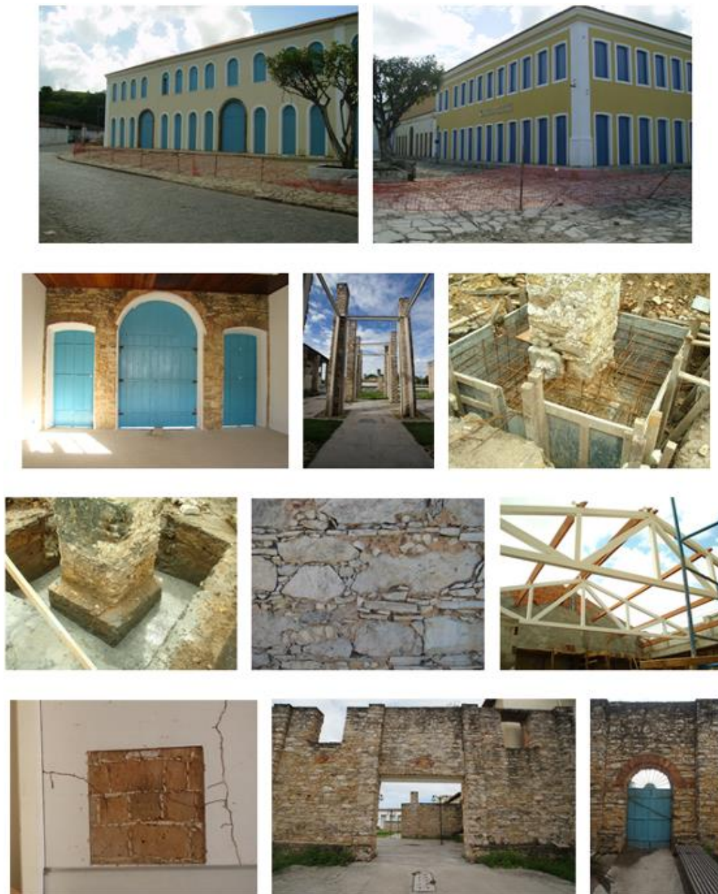
Figura 3- (acima): esquerda – “Trapiche Santo Antônio” – salas de aula vista externa “restauração” da fachada produzindo um aspecto neocolonial, direita – “Restauração” do Sobrado 159, uma atmosfera neoclássica misturada com um neocolonial (internamente totalmente reconstruído). Fonte: autores, nov. 2009; (centro acima): esquerda – Consolidação dos arcos das vergas superiores das portas, centro – Perfis metálicos para consolidar o corpo das colunas de pedra, direita – Consolidação da base – fundação das colunas de pedra. Fonte: Acervo da UFS, set. 2008; (centro abaixo): esquerda – Consolidação com sapata de concreto e armadura de ferro (gaiola) da base de uma das colunas de
