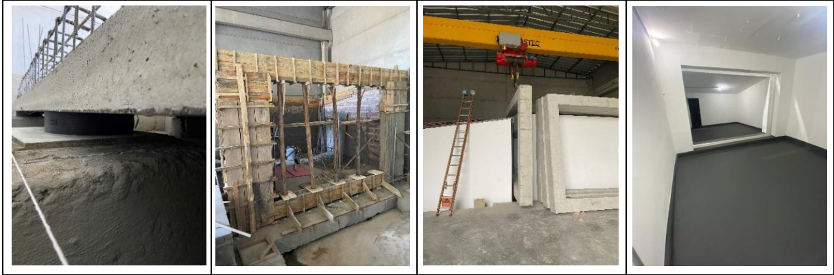
Figura 3: Construção das câmaras acústicas.
