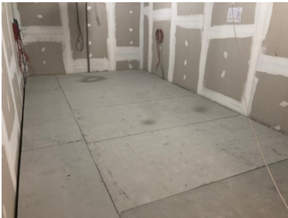
Figura 7: Piso flutuante finalizado, sem conexão com as paredes externas.
