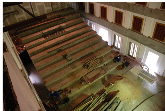
Figura 12: Reforma da Sala C2020, com destaque na elevação da plateia [3].
