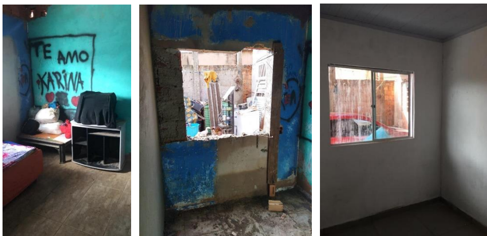
Figuras 13, 14 e 15: Evolução do quarto / execução de acabamentos e instalação de novas
