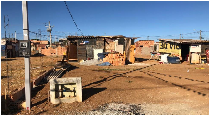
Figura 04: autoconstruções no Sol Nascente
