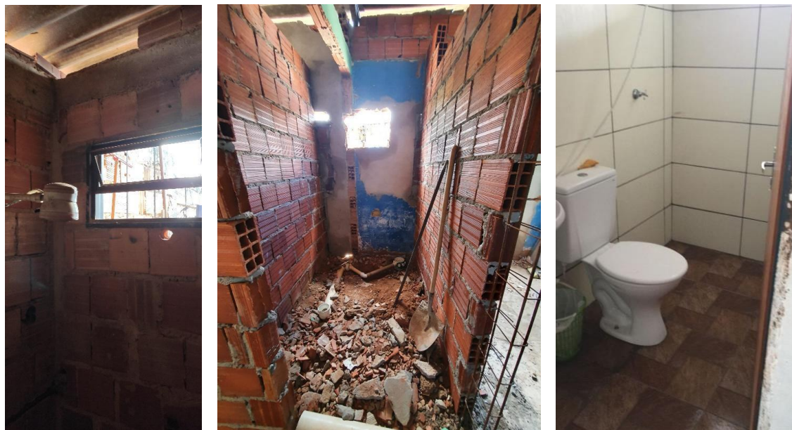
Figura 08, 09 e 10: Reforma do banheiro
