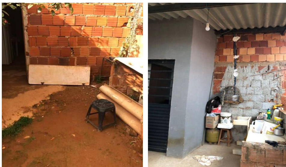
Figuras: 26 e 27: Evolução da área de serviço e construção do Hall de acesso ao quarto
