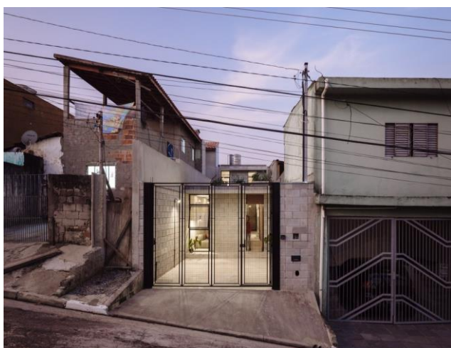
Figura 1: Vista Frontal da Casa Vila Matilde
