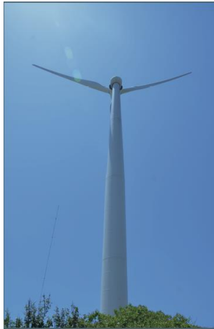
Figura 4: Aerogerador fabricado pela Impsa e de modelo IV-77 localizado em parque eólico na região do Aracati/CE. Registro feito a partir do ponto de medição (retirado de Lima [5]).
