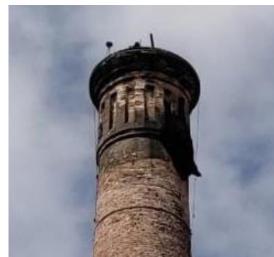
Figura 12: Ninho de cupim identificado no topo da chaminé.
