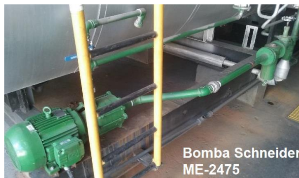
Figura 12. Bomba Schneider ME-2475, que alimenta a caldeira ATA-24 (adaptado de Feghali, 2016).
