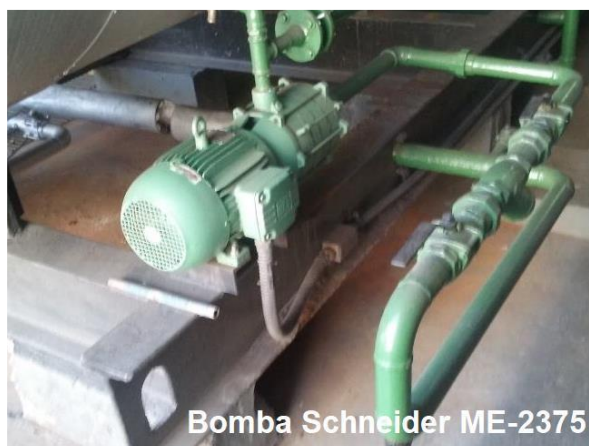
Figura 14. Bomba Schneider ME-2375, que alimenta a caldeira ATA-22 (adaptado de Feghali, 2016).
