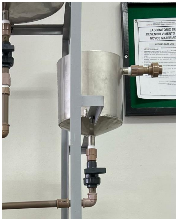
Figura 5. Reservatório de óleo acima do decantador de camada líquida coalescente
