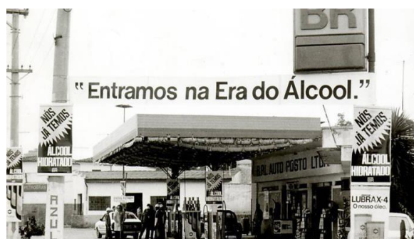
Figura 2. Posto de combustível em 1975.
