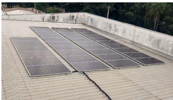
Figura 2. Foto do telhado do bloco. Fonte: foto retirada pelo autor.
