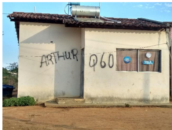
Figura 3. Unidade Habitacional Demarcada por Ocupante
