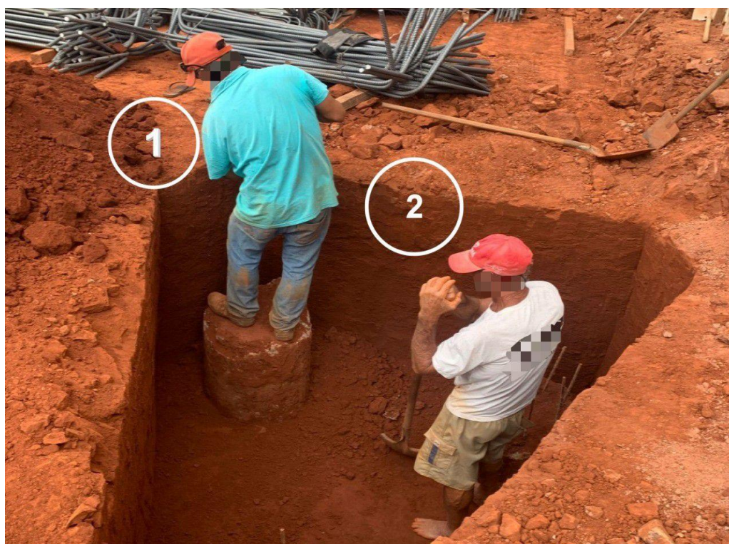
Figura 2 - Trabalhador no canteiro de obras no Centro
