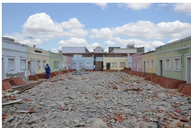
Figura 10: Obra de reforma no interior do Mercado Público, ano de 2017. Fonte: Francisca Morais de Aquino (2018, p. 336)
