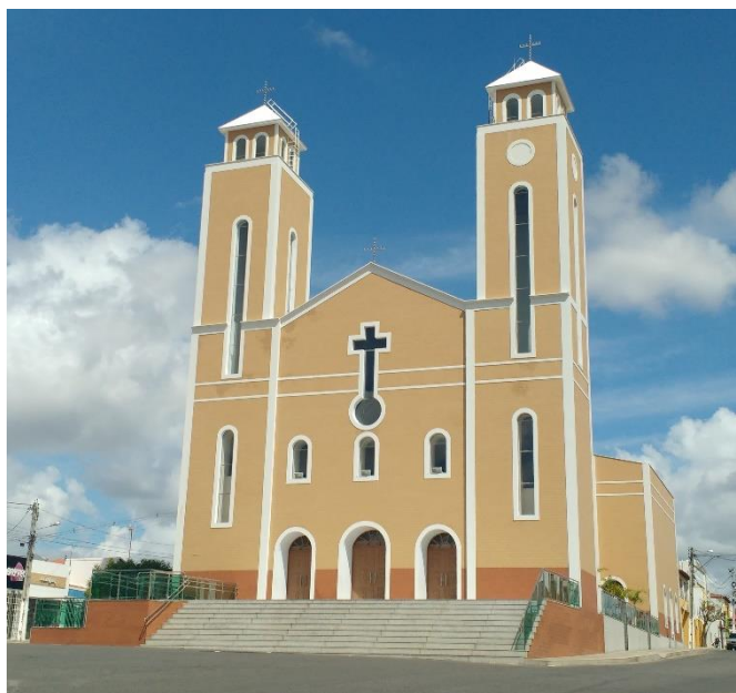
Figura 6: Fachada da Igreja da Matriz, após conclusão das obras em 2015. Fonte: Francisca Morais de Aquino (2018, p. 322)
