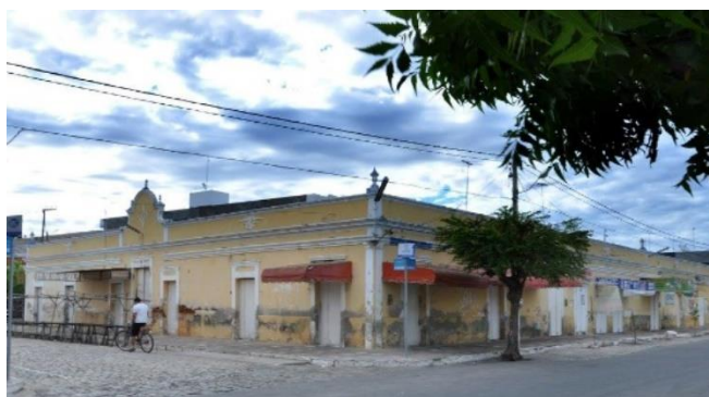
Figura 7: Mercado Público Municipal, antes da descaracterização. Fonte: Antônio Medeiros de Dutra (2014)
