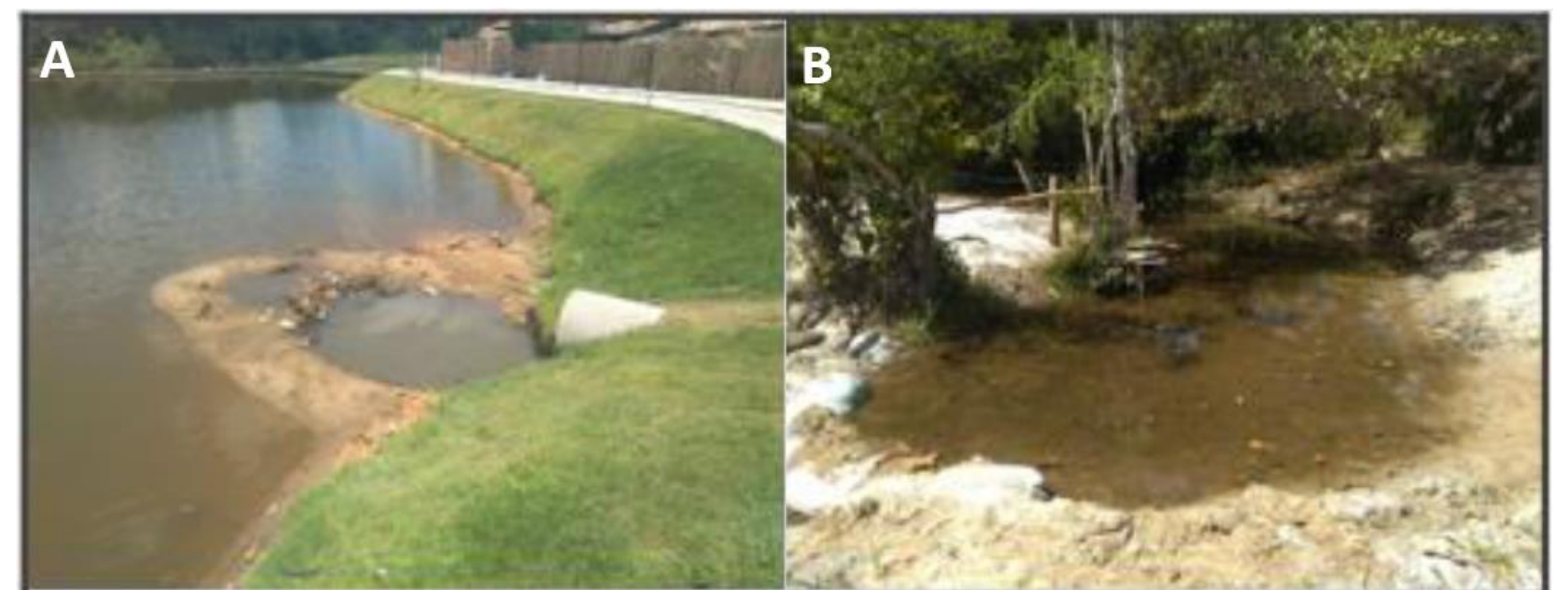
Figura 02- Barragem (A), Nascente (B)
