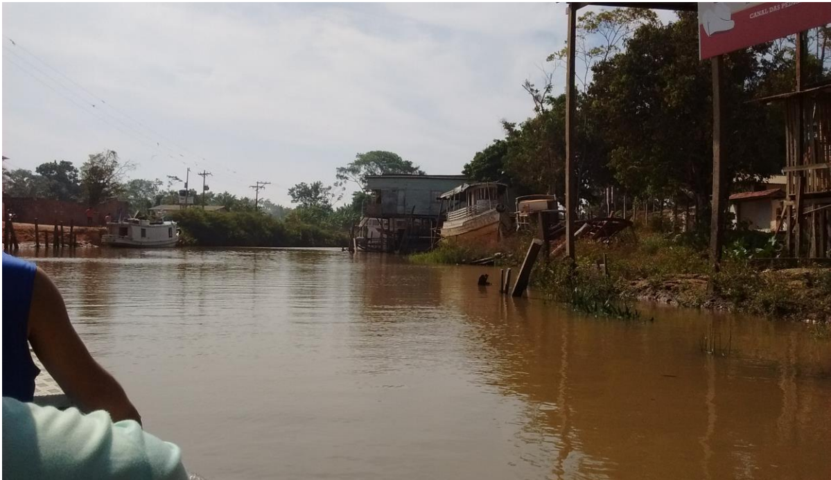
Figura 2 – Foz do canal das Pedrinhas, ponto 1.
