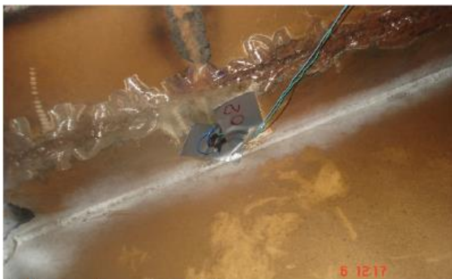
FIGURA 20. Exemplo de ponto instrumentado na viga principal da "Retomadora de Minério". Fonte: Autor (2018).
