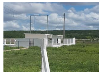
Figura 3: Sala de proteção da capacidade.
