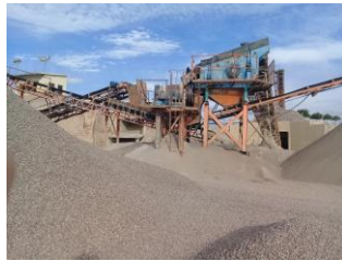
Figura 2: Máquina de britagem.
