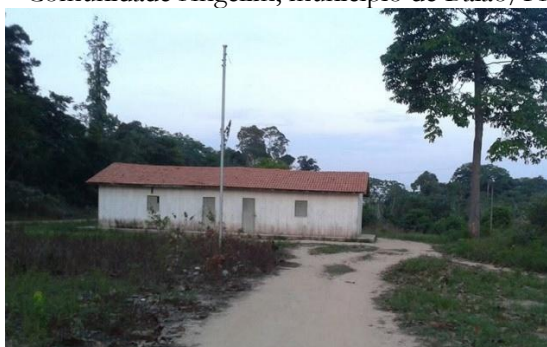
Figura 4 – Bloco de anexo da escola da Comunidade Angelim, município de Baião/PA
