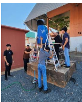
Figura 1 – Processo de montagem do reservatório de água.
