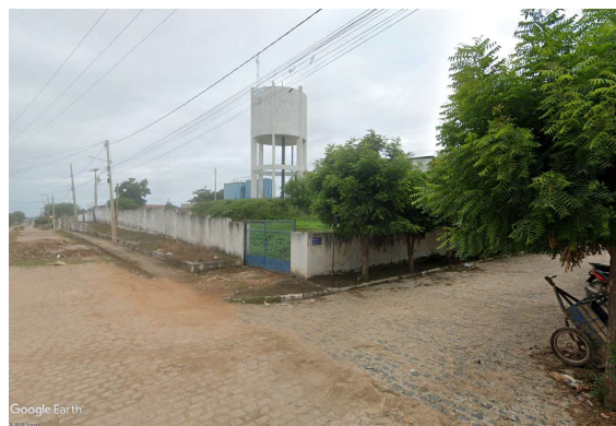
Figura 2. Reservatório elevado e unidades de tratamento do sistema de abastecimento, Triunfo (PB). Fonte: Google Earth (2026).
