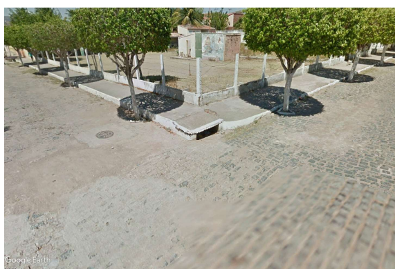
Figura 4. Elemento de microdrenagem em via de calçamento poliédrico, Triunfo (PB). Fonte: Google Earth (2026).
