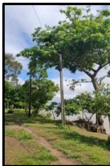
Figura 7: Poste de energia
