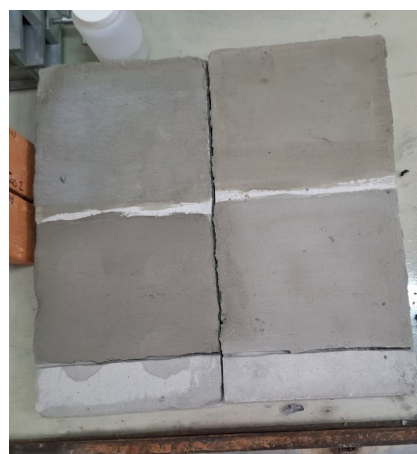
Figura 4. Aspecto de duas placas de revestimento após a aplicação das duas argamassas.
