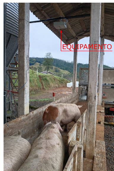
Figura 8: Instalação do equipamento na rampa de carregamento.
