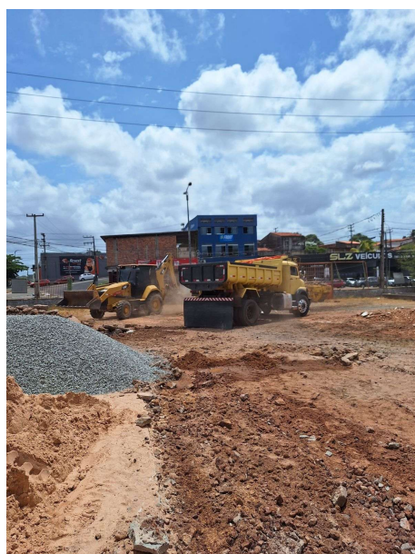
Figura 6. Coleta e transporte de materiais observados durante a obra. Fonte: A autora (2026).
