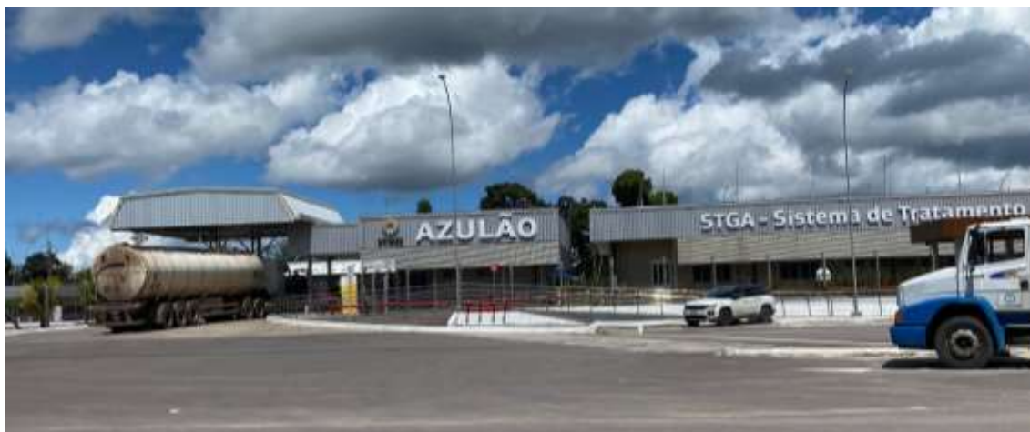
Figura 7 - Complexo Termelétrico Azulão 950.
