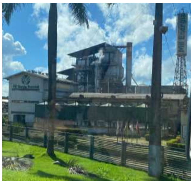
Figura 6 - Subestação Mil Madeira Energia.
