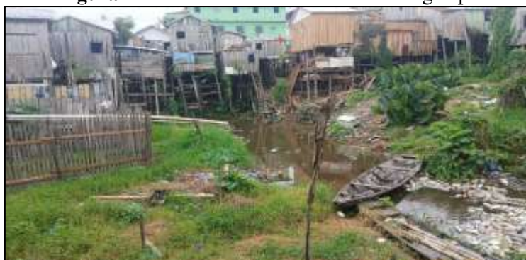
Figura 4 – Encanamentos direcionados os igarapés.
