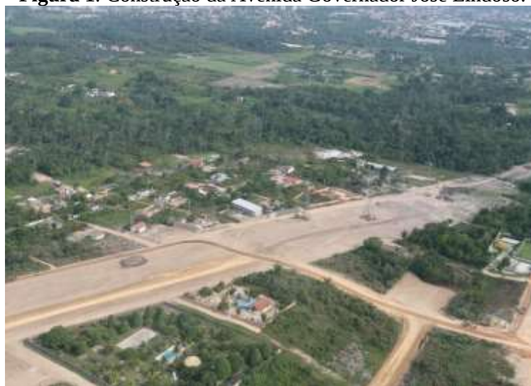
Figura 1: Construção da Avenida Governador José Lindoso.
