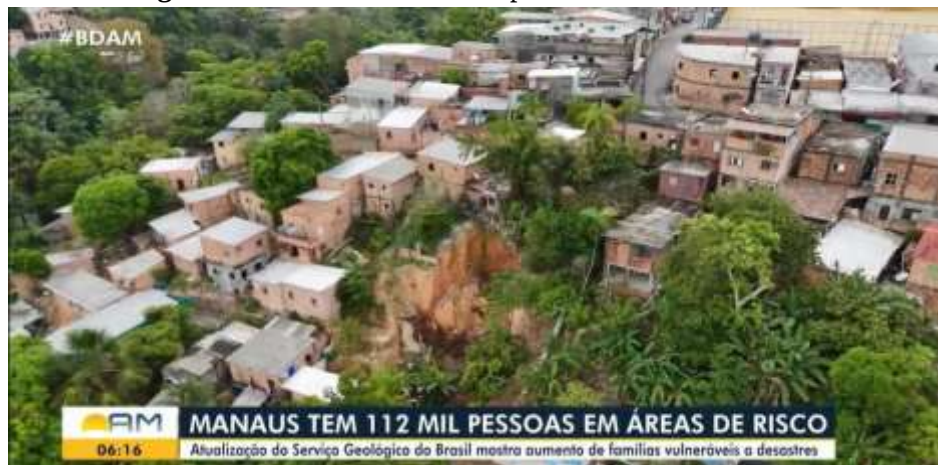
Figura 2 - Manaus tem 112 mil pessoas em áreas de risco
