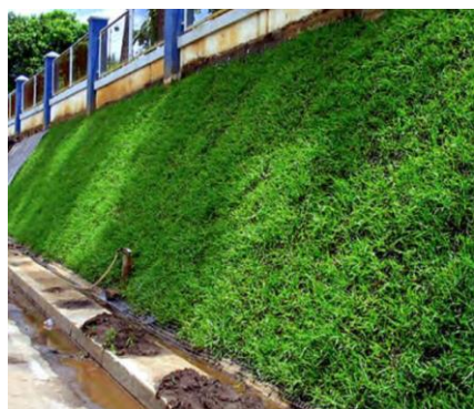
Figura 7. Muro de arrimo verde. Fonte: NTC Brasil (2015).
