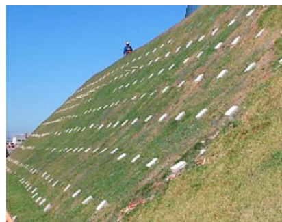
Figura 9. Solo grampeado. Fonte: Solotrat (s.d.).
