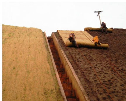
Figura 8. Contenção em geocélula ou biomanta. Fonte: Terragreen Bioengenharia (s.d.).
