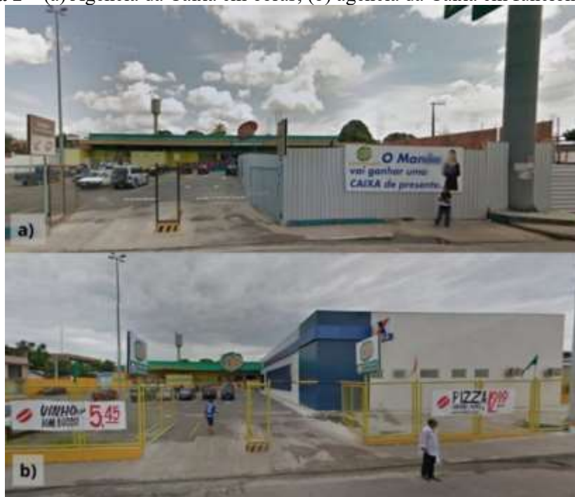
Figura 2 – (a) Agência da Caixa em obras; (b) agência da Caixa em funcionamento.
