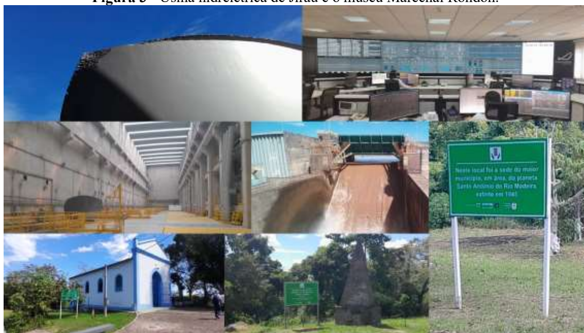
Figura 3 - Usina hidrelétrica de Jirau e o museu Marechal Rondon.
