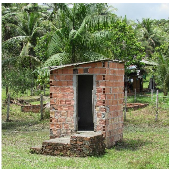
Figura 18. Sanitário - Comundiade Nova Canaã.
