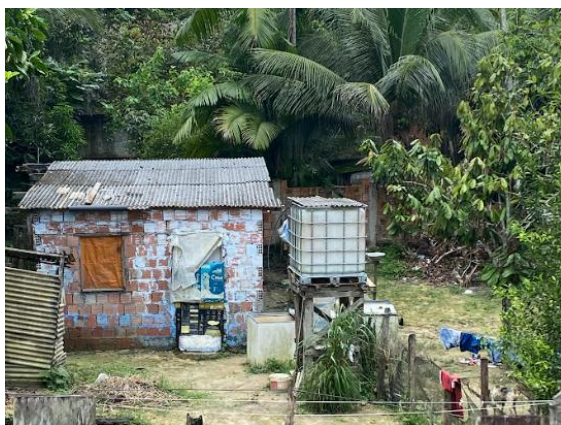
Figura 17. Reservatório de água em residência - Comundiade Nova Canaã.
