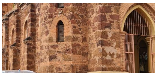
Figura 2. Fotografia da igreja São Domingos, em Uberaba/MG (cima) construída com rocha tapiocanga, e detalhe da parede lateral da igreja (baixo).
