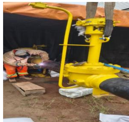
Figura 3: Soldagem em área externa para conexão entre duto de aço e válvula de gaveta.
