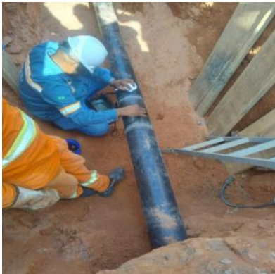
Figura 1: Inspeção ultrassônica em vala escavada
