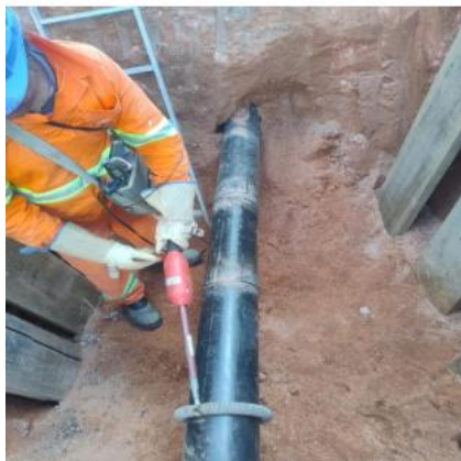
Figura 2: Teste de descontinuidade do revestimento em tubulação de aço
