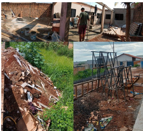
Figura 1: Condições de organização, circulação e gestão de resíduos no canteiro de obras.
