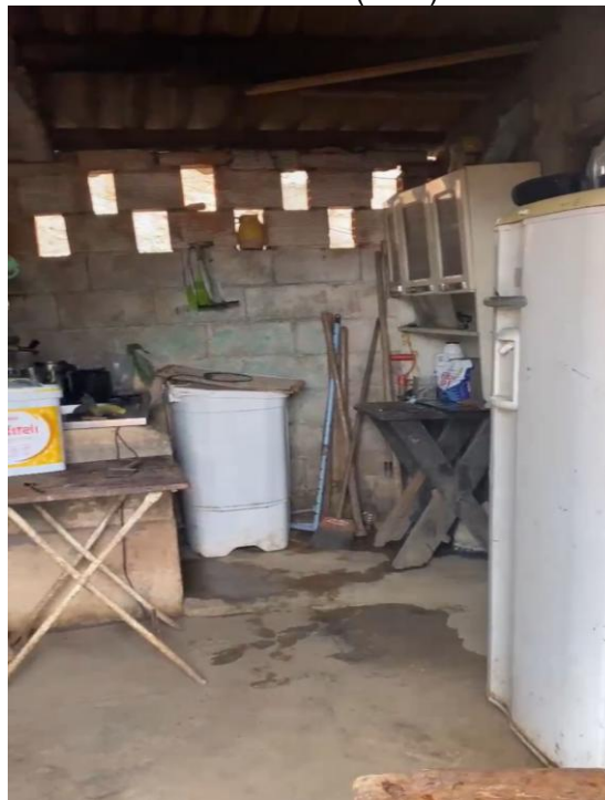
Figura 2 – Cozinha / área de serviço da residência (atual)
