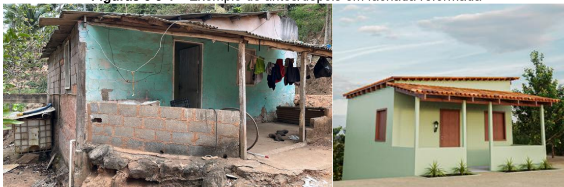
Figuras 3 e 4 – Exemplo de antes/depois em fachada reformada
